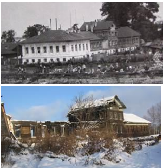
Рисунок 1. Ул. Набережная VI Армии, д. 81. Историческое фото.
