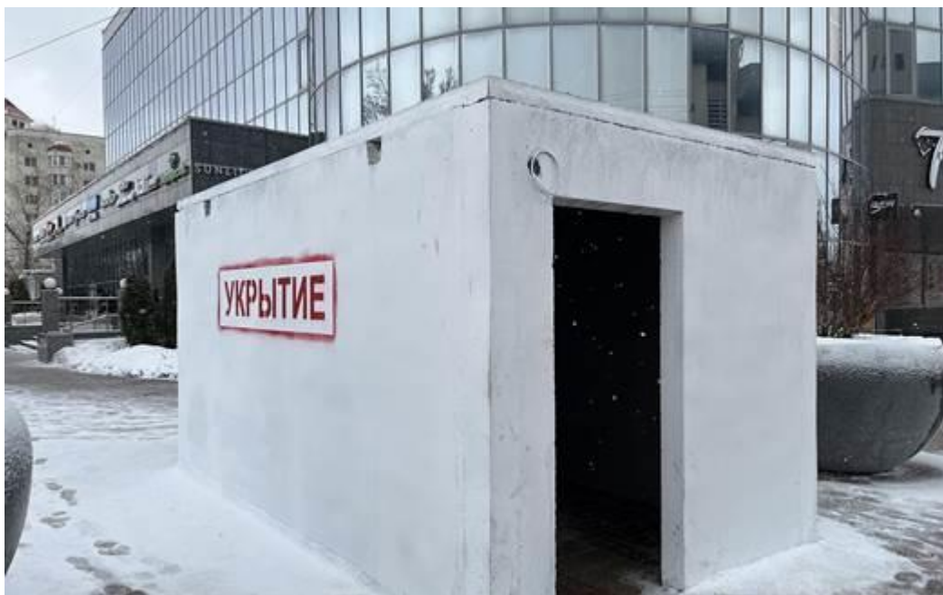
Рисунок 3. Модульное защитное сооружение в Белгородской области
